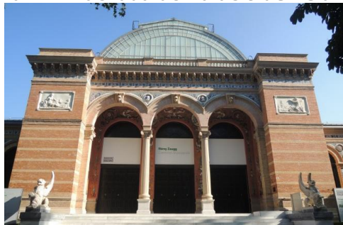
Figura 44 - Fachada do Palácio de Velazquez
