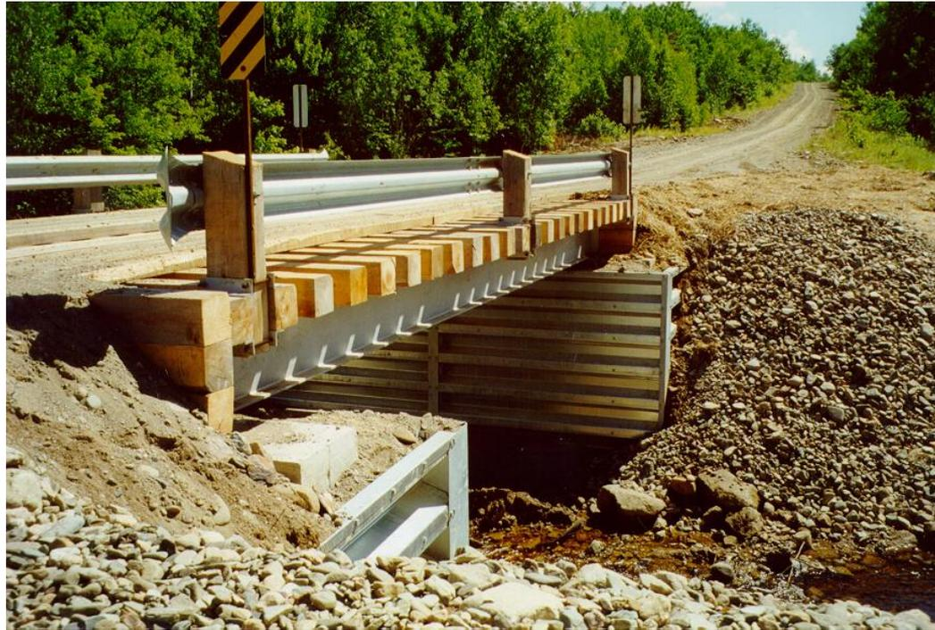
A construção de pontes metálicas é rápida, em virtude da montagem prévia de alguns componentes, e com previsão de durabilidade maior (ex. custo de US\$12,000).
