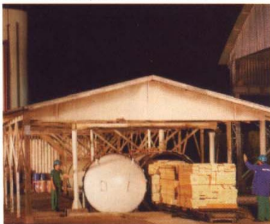
Vista da autoclave para tratamento da madeira
