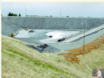
Implantação de manta de impermeabilização de Polietileno de Alta Densidade (Manta PEAD).
