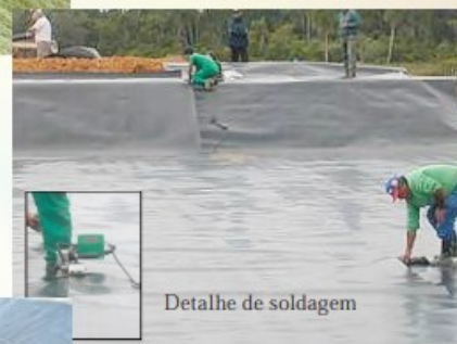
Construção da rede de drenagem de gases residuais e de chorume no Aterro Sanitário de Juiz de Fora, MG.
