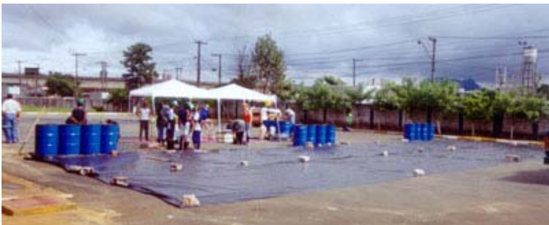
Instalações de trabalho
