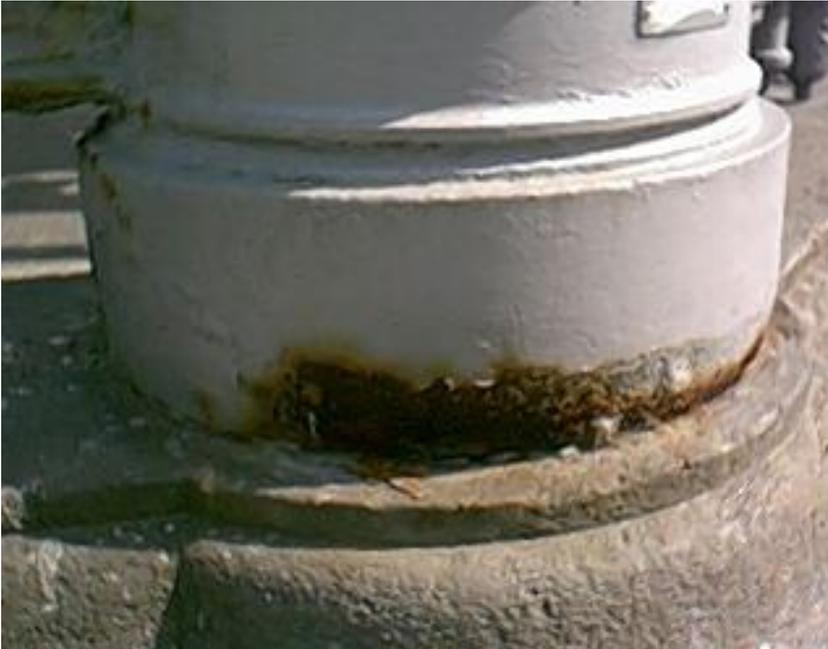
Corrosão em fresta formada na junção de um mastro metálico e do concreto onde está assentado. Caso muito frequente.
