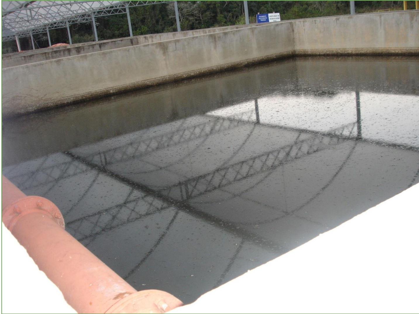
Segundo tanque – com lodo
