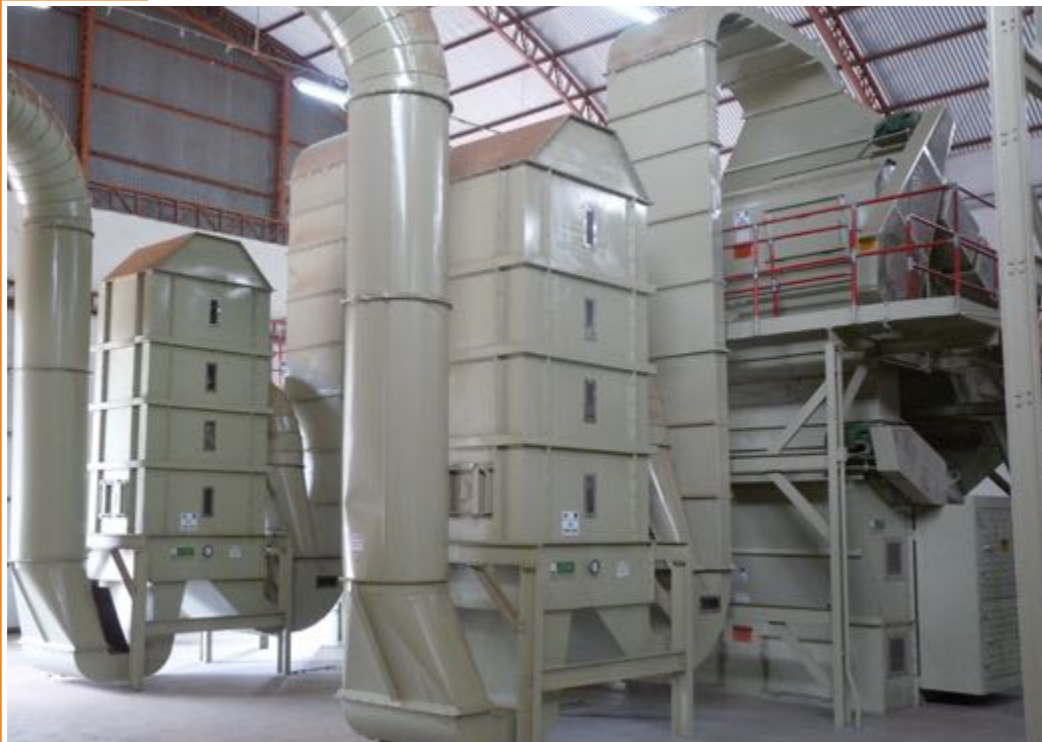
Figura 8. Secagem com torre sem gavetas em linhas duplas
