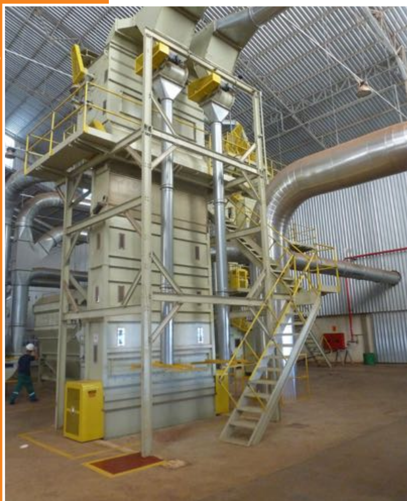
Figura 5. Torre de regulação de fluxo montada em cima do chão
