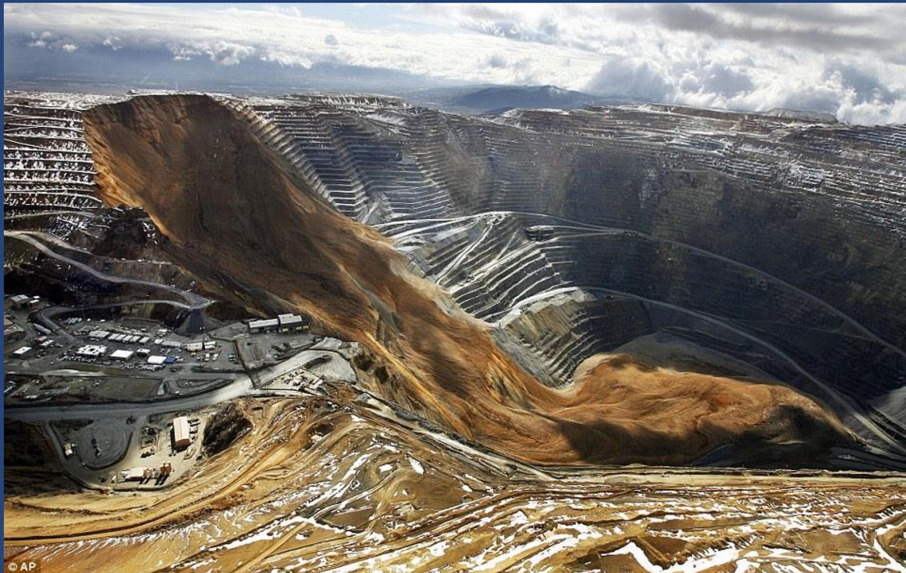
Deslizamento de talude na mina **de cobre de Bingham Canyon**, arredores de Salt Lake City, Utah. A produção da mina caiu a metade depois do evento crítico.
