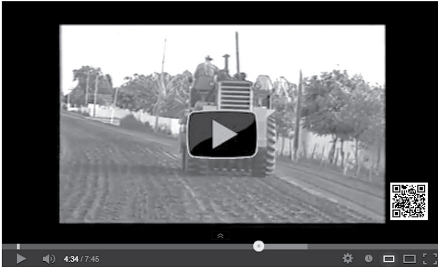
FIGURA 2.16 Processo de construção de estrada [ LOI2007 ].
