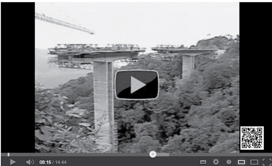
FIGURA 2.17 Construção da Rodovia dos Imigrantes [ EFF2012 ].
