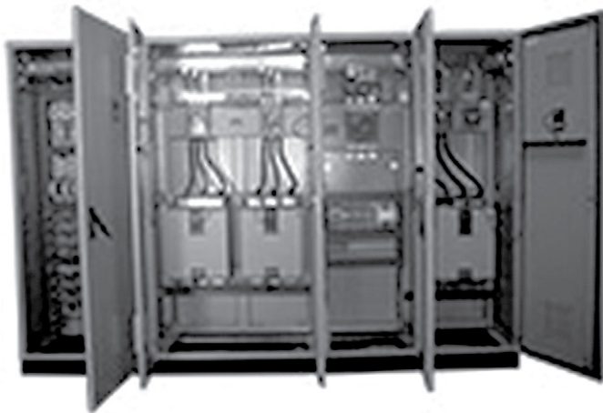
FIGURA 7.24 Painéis de relés.
