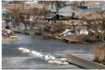
**FIGURA 1.54** Um grande helicóptero tenta fazer reparos de emergência na barragem violada da 17ª Rua vários dias depois que o furacão Katrina atingiu Nova Orleans e derrubou esta seção da barragem e do dique. Grandes pedaços da barragem podem ser vistos por cerca de 14 metros para interior. (Foto cortesia do Corpo de Engenheiros do Exército dos Estados Unidos)
