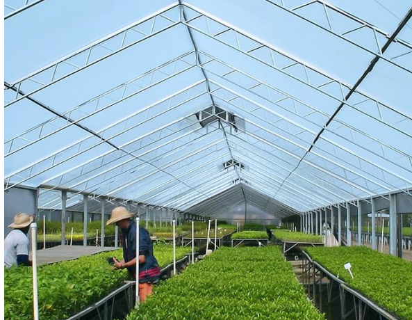
Lanternim em duas-águas
