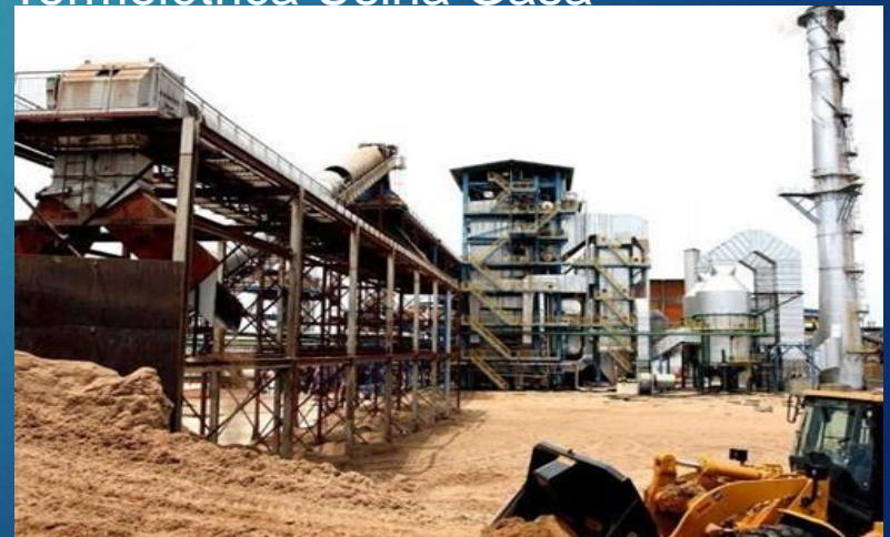
Termelétrica Usina Gasa
