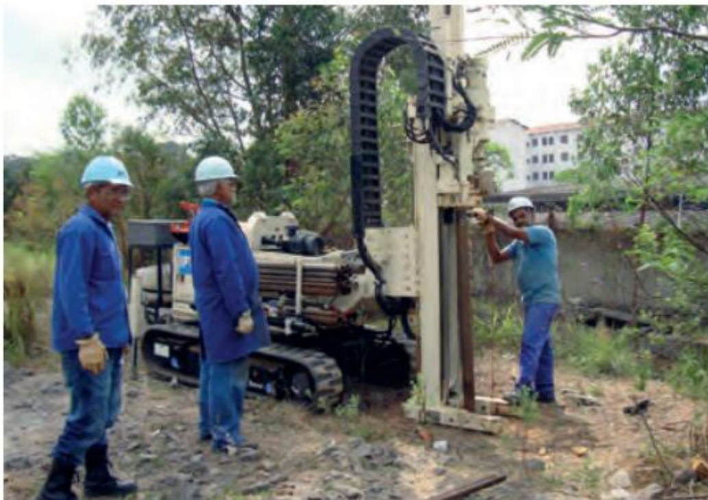
Exemplo de liner com cravamento mecânico
