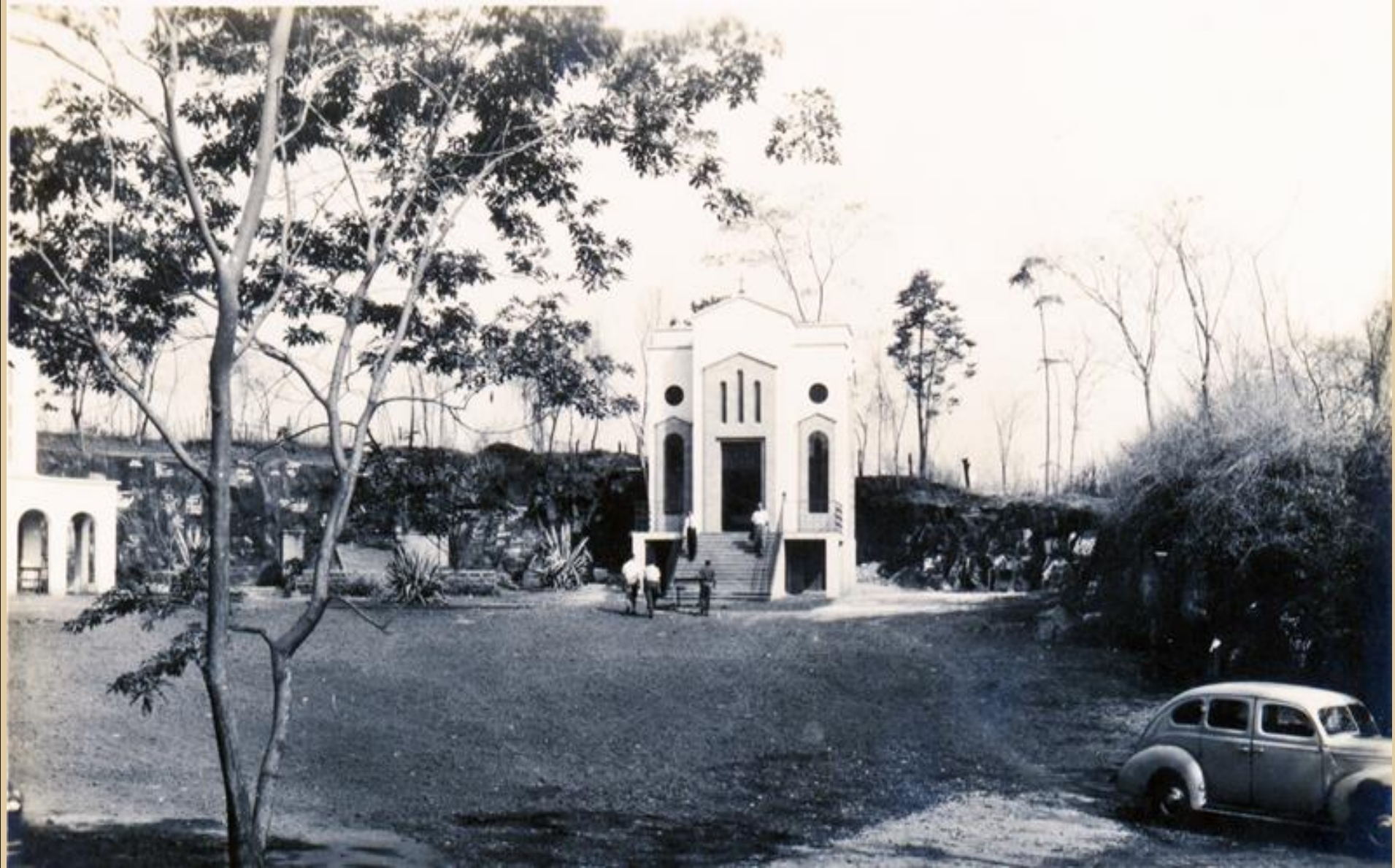
Santuário das Sete Capelas, vista parcial. Obras da construção das três primeiras capelas. Data: 1940/1950. Estúdio fotográfico: Foto Postal Colombo
