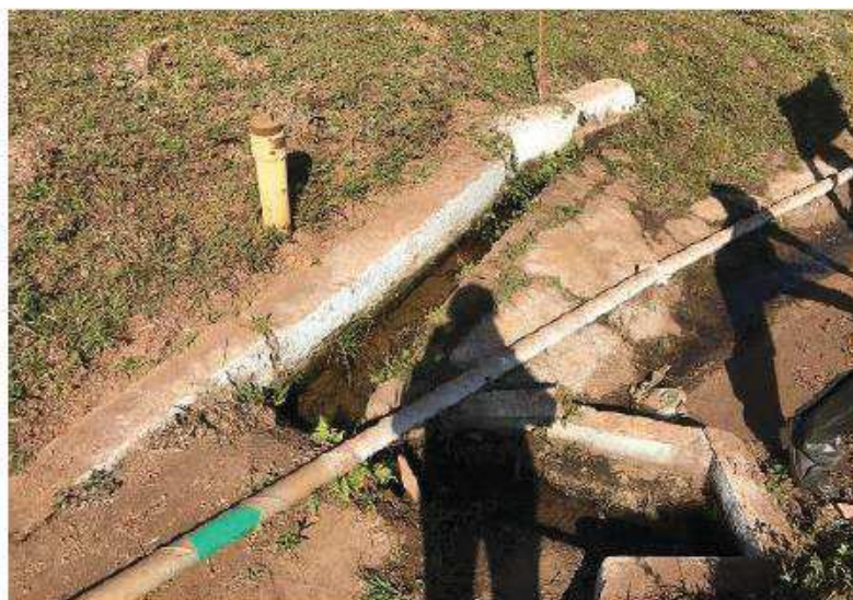
Foto 15 – Surgência de água sob dispositivo de drenagem no contato do maciço com a ombreira direita.
