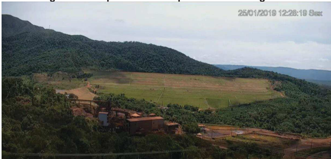
Figura 4 – Sequência do rompimento da barragem B1
