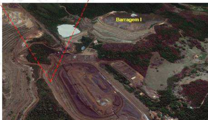
Local de instalação do radar.
