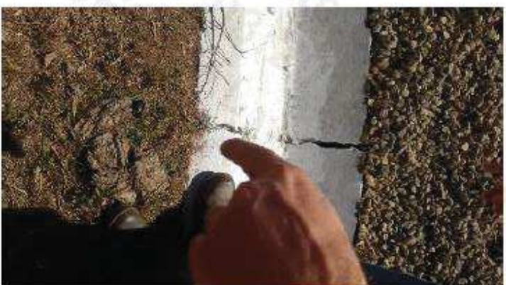
Foto 5 – Canaletas trincadas na região do maciço na ombreira esquerda – EL. 937 m.
