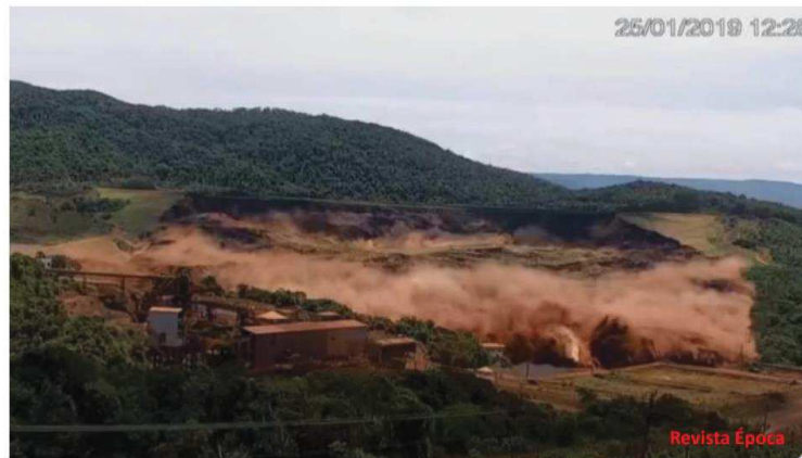
Figura 10: Momento do rompimento da barragem B1.
