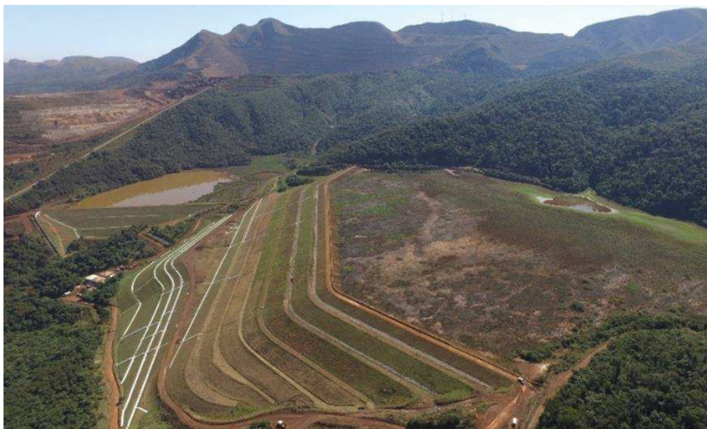
Figura 1 – Vista aérea da barragem B1
