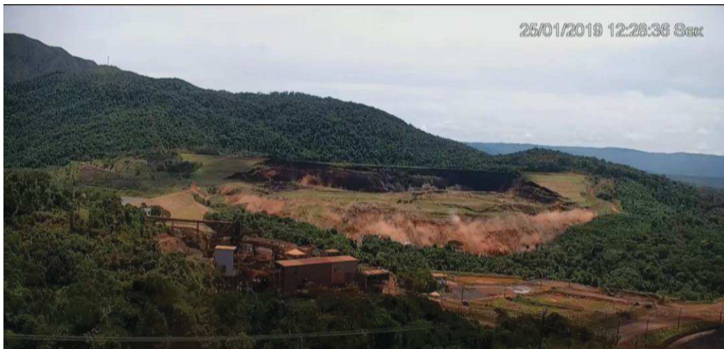
Figura 4 – Sequência do rompimento da barragem B1 (cont.)
