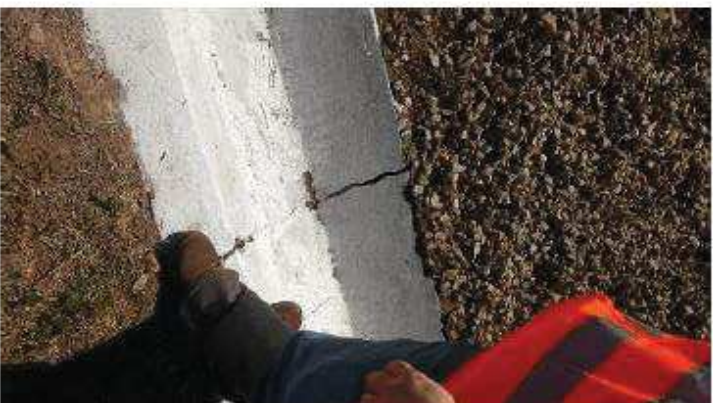
Foto 5 – Canaletas trincadas na região do maciço na ombreira esquerda – EL. 937 m.
