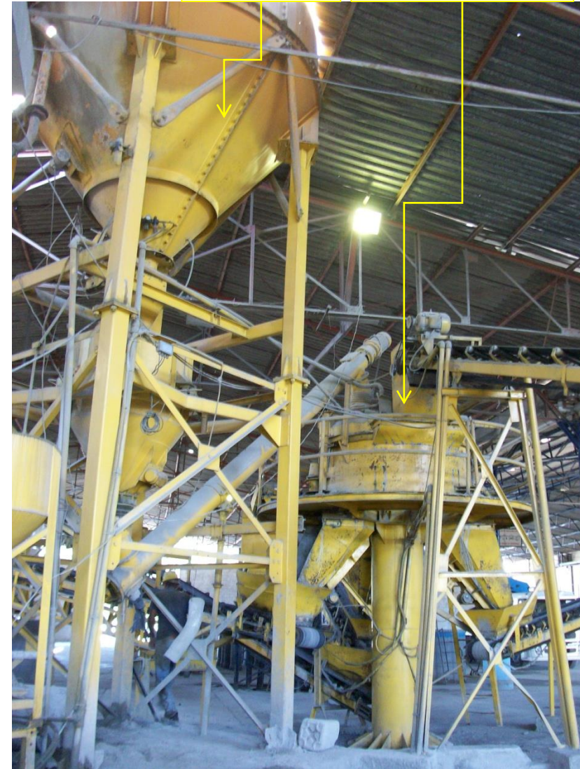
Silo de cimento
