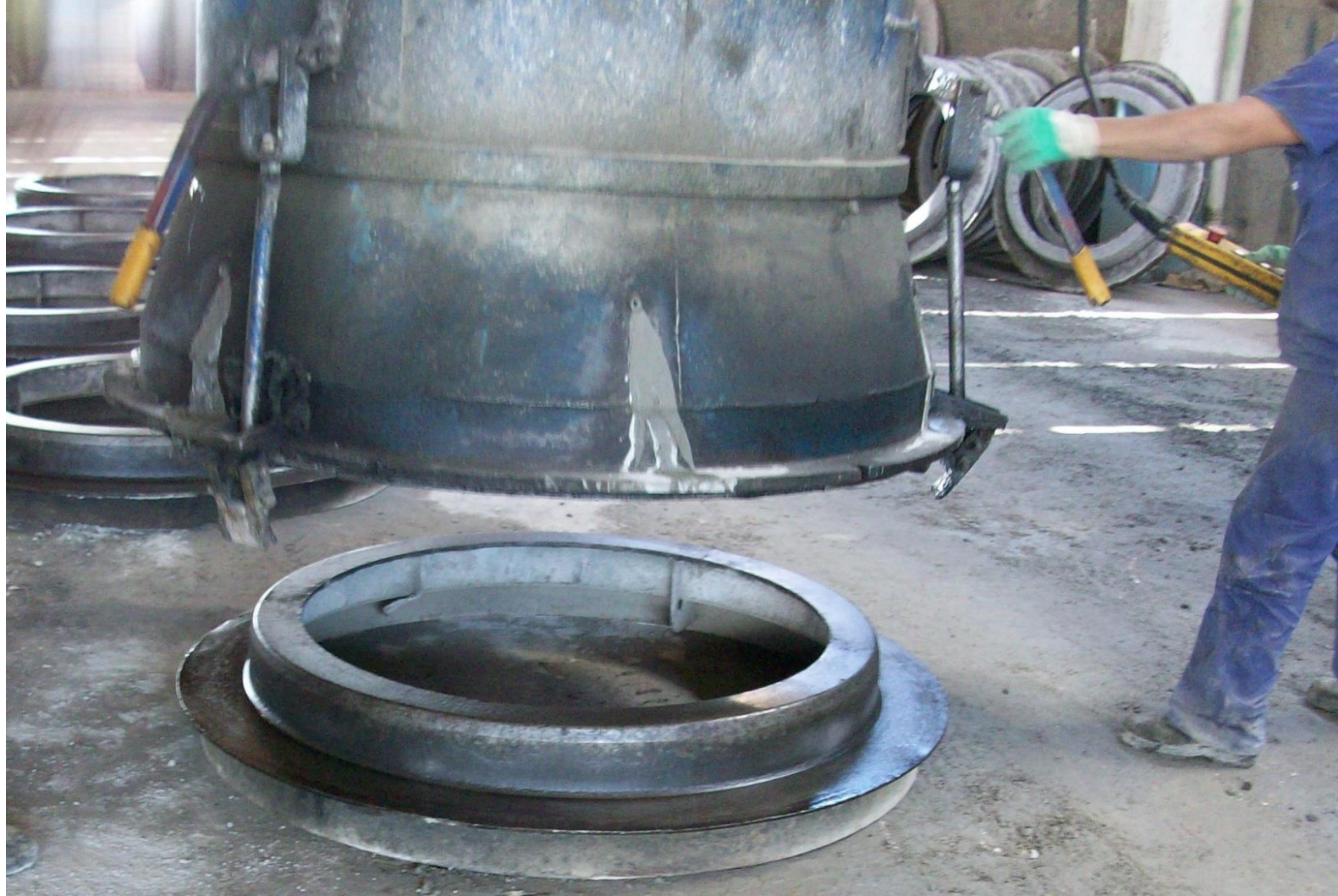
Anel de base permanece após desfôrma
