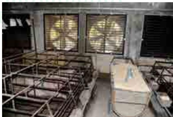
**Fotos 1 e 2** - Sistema de climatização em túnel em gestação. Vedação do teto e das laterais e entrada de ar resfriado numa das extremidades do barracão, com exaustão na outra extremidade.
