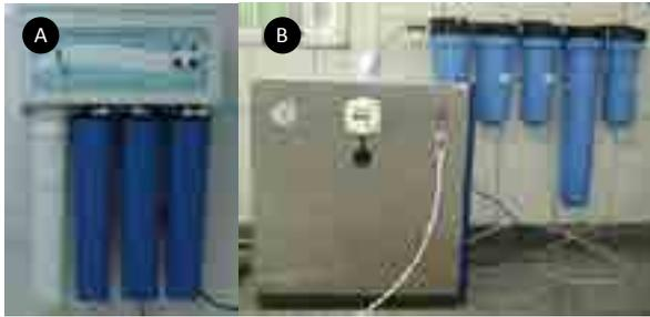
**Foto 3** – Sistema de Osmose Reversa para purificação de água, associados à pré-filtração.
