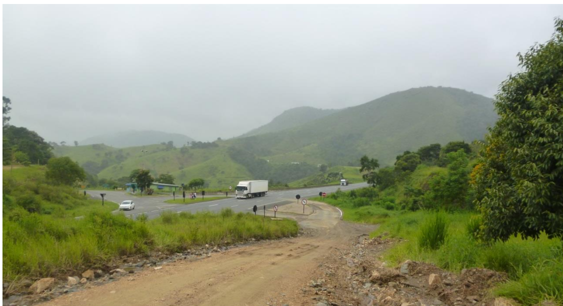
Foto 1: Rodovia Regis Bitencourt (BR - 116) cortando o quilombo Pedra Preta. (jan/2015) Foto: Carina Bernini
