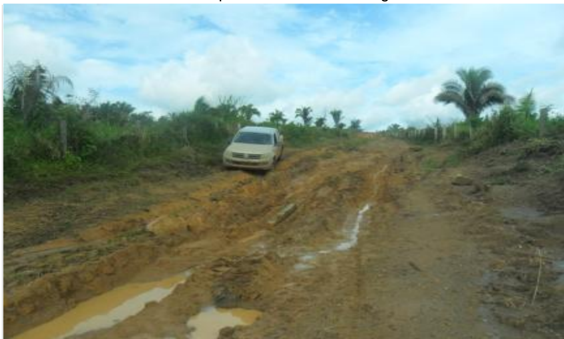
Foto 3 - Estrada que dá acesso ao complexo de fazendas Divino Pai Eterno, no município de São Félix do Xingu
