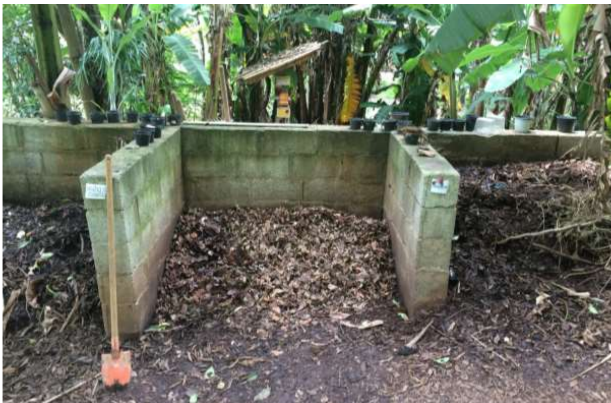
Figura 51 – A composteira da Praça Dolores Ibárruri, dentro da área da Horta das Corujas: até 2015, era a única composteira em praça pública do município de São Paulo. A estrutura de blocos de concreto estruturais apresenta três repartições, onde são depositadas as folhas e galhos provenientes da poda local e, então, se aguarda o processo natural de decomposição da matéria orgânica. São Paulo/SP, Brasil. Foto de fevereiro de 2015. Crédito: Gustavo Nagib.
