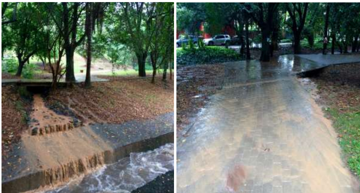
Figuras 43 e 44 – Quando o volume pluviométrico é elevado e concentrado em rápidos temporais de verão, as biovaletas, mesmo concretadas (à esquerda), cumprem a sua função, porém não conseguem dar conta do grande escoamento superficial que desce da “parte alta” da Praça das Corujas: verifica-se, à direita, a descida de lama pelo passeio calçado. São Paulo/SP, Brasil. Fotos de fevereiro de 2015. Crédito: Gustavo Nagib.
