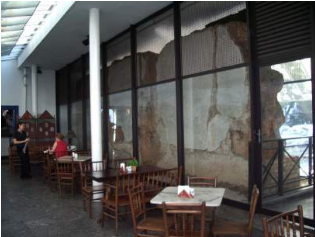
Figura 3 – Aspecto parcial da parede remanescente da antiga capela (São Paulo – Brasil). Foto: Fabiana Manzato
