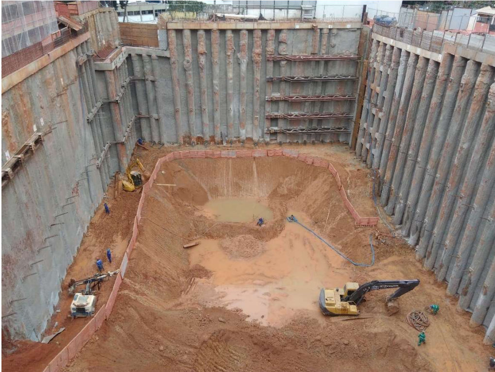
Figura 15 – Escavação de grande profundidade, com vários níveis de tirantes complementados com longarinas.
