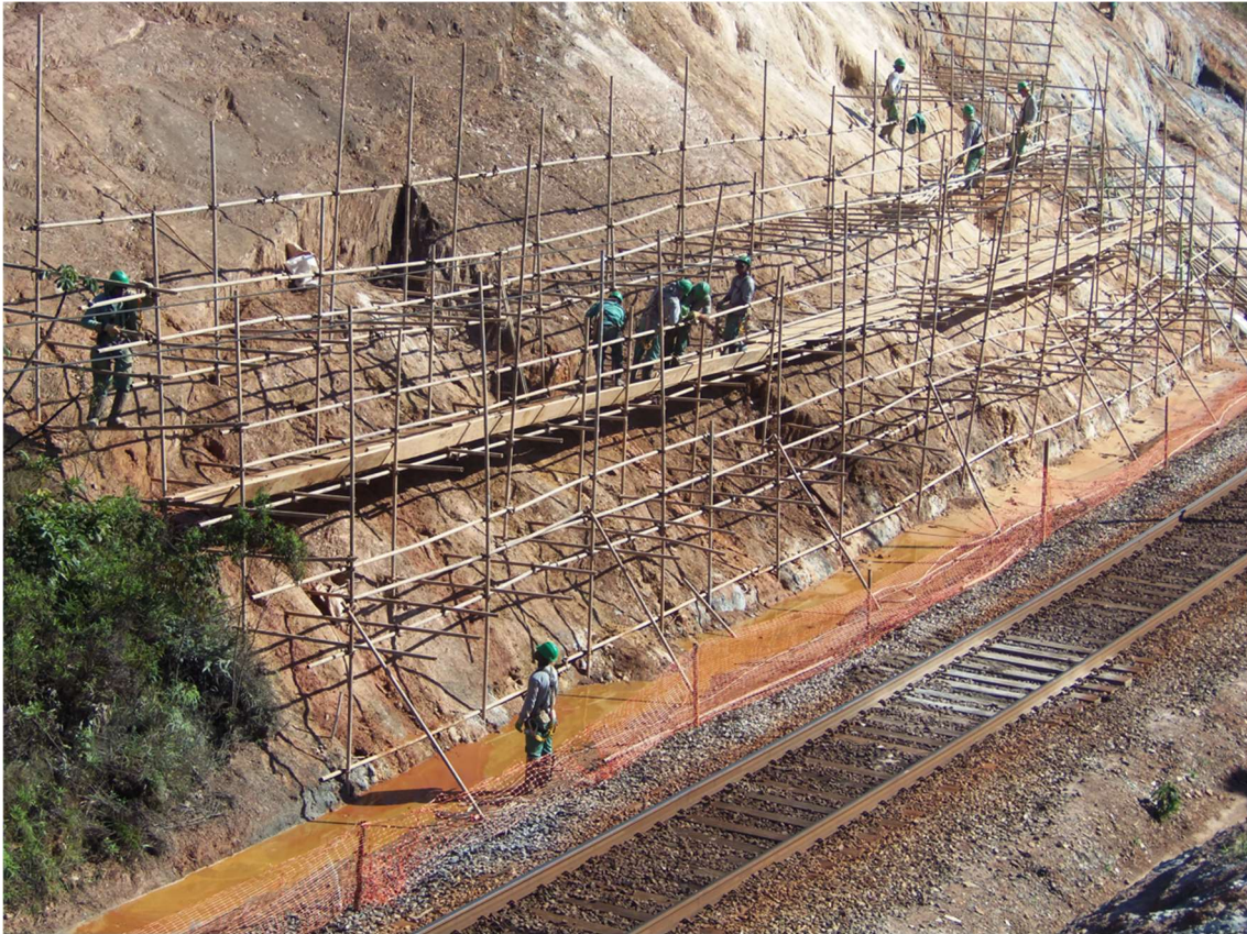
Figura 6 – Execução de reforço com solo grampeado em talude existente (cortesia Solotrat).
