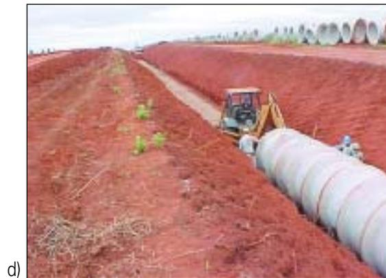
**Alguns tipos de base para tubos de concreto:** a) base de concreto para linha simples; b) base de concreto feita em etapas para linha simples; c) outro exemplo de base de concreto para linha simples; d) base com conformação do solo para linha simples.
