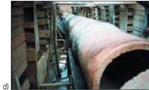
*Alguns tipos de instalação de tubos de concreto: a) linha dupla de tubos instalados em aterro com projeção positiva; b) linha simples de tubos instalados em aterro com projeção positiva; c) linha simples de tubos instalados em vala com largura variável e d) linha simples de tubos instalados em vala, com escoramento de madeira.*
