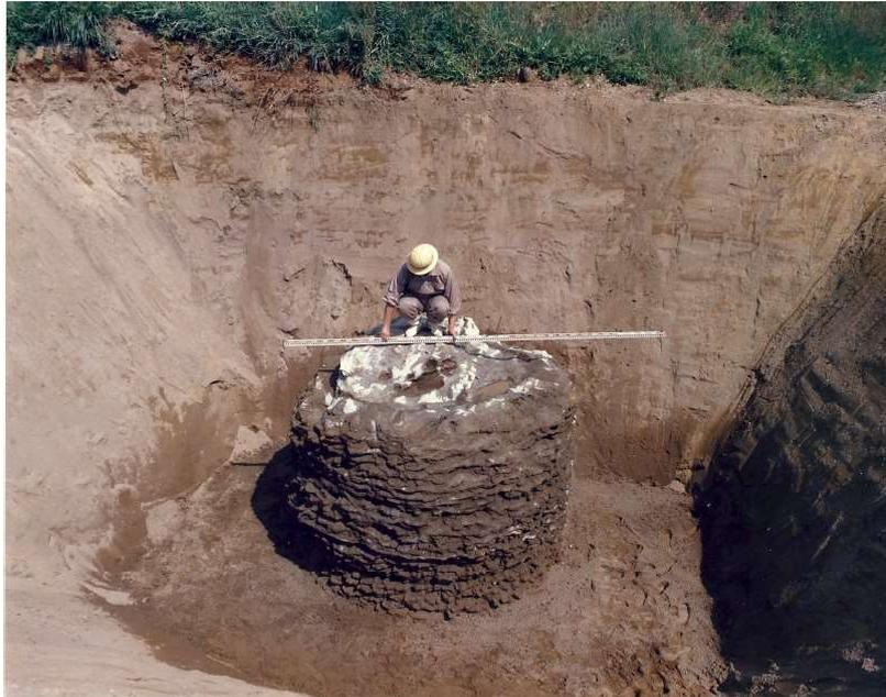
**Figura 23** – Coluna de solo-cimento formada no solo com uso de “jet-grouting”.
