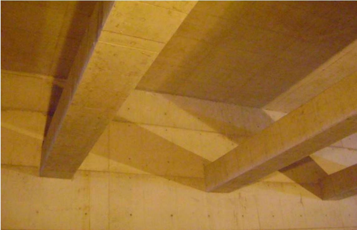
**Figura 14** – Pergolado constituído por barras de concreto armado espaçadas que tem função de fornecer apoios horizontais para as paredes de uma galeria enterrada.
