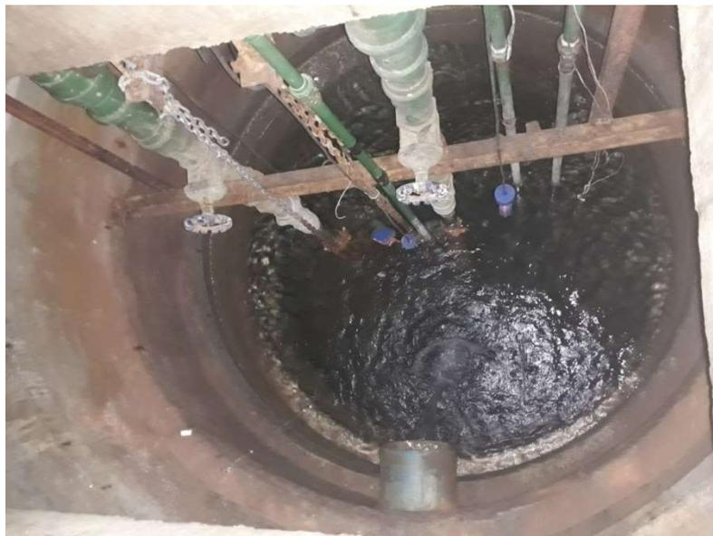
**Figura 7** – Poço de bombeamento associado à câmara de ventilação e drenagem do Edifício Garagem do Aeroporto de Congonhas.
