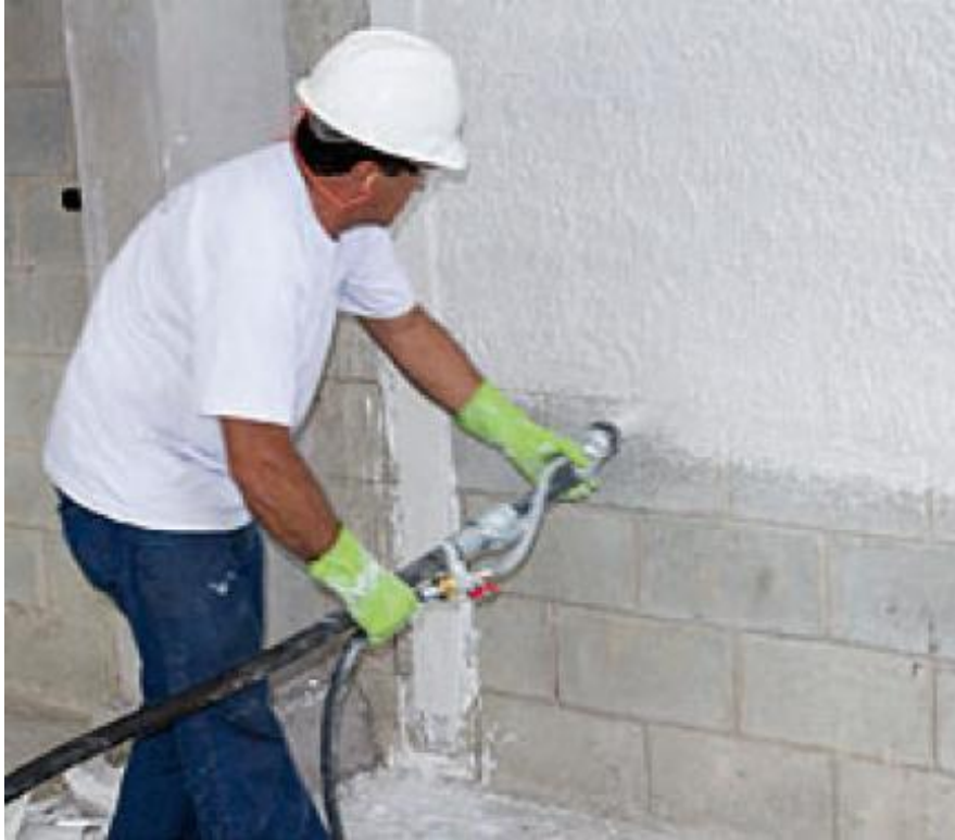
Revestimento de gesso
