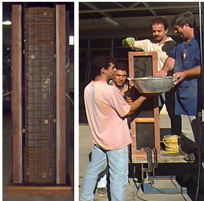
Foto 5.2 - Fotos fôrma e moldagem dos pilares reforçados
