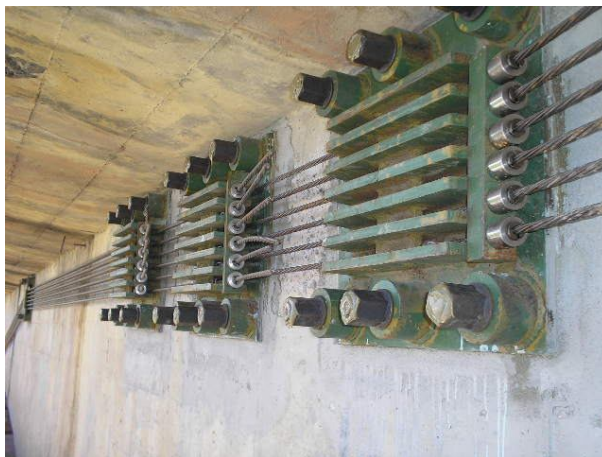
Foto 2 – Dispositivos utilizados para a ancoragem das cordoalhas nas extremidades da viga, fixadas por meio de barras Dywidag.
