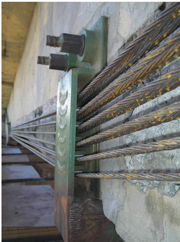
Foto 3 – Detalhe de um desviador metálico na parte inferior da viga após a fixação.
