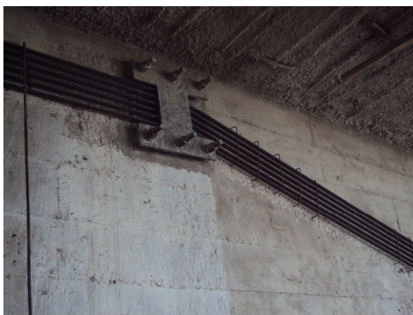
Foto 4 – Desviadores metálicos das cordoalhas na parte superior da viga (nos apoios).
