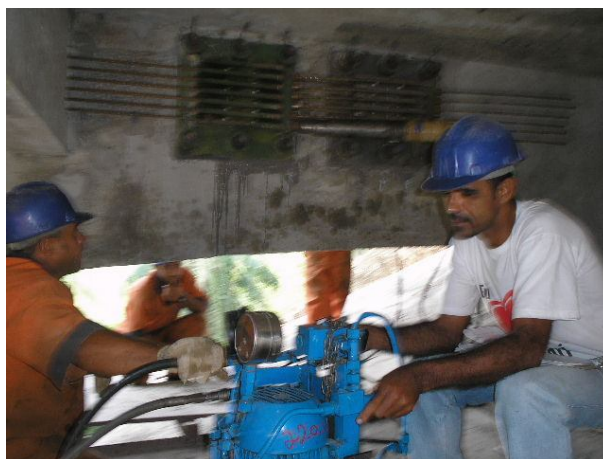
Foto 5 – Aplicação de protensão em cada cordoalha.
