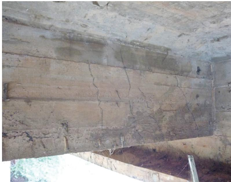
Figura 3. Fissuras de cisalhamento em ponte provocada pela passagem de veículos com carga excessiva, não prevista em projeto.
