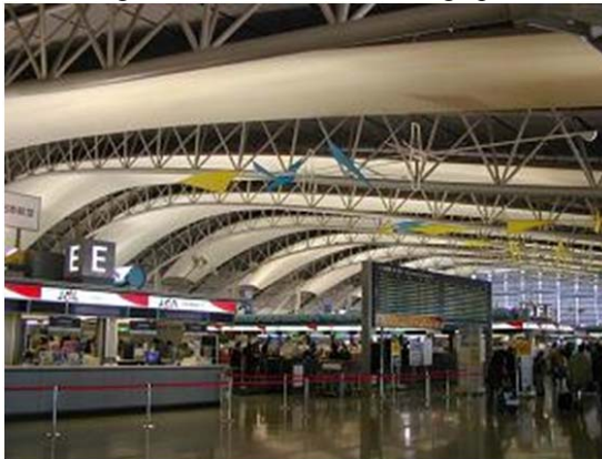
Figura 3.13 Cobertura de um aeroporto.
