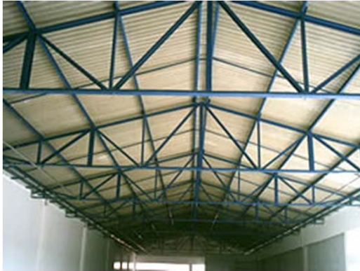
Figura 3.11 Cobertura de um galpão.
