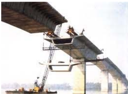
Figura 17.1 Ponte em múltiplos vãos.
