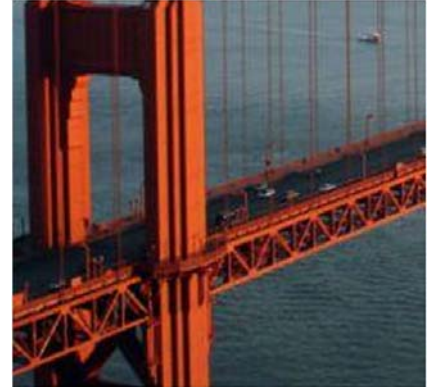
Figura 3.12 Tabuleiro de uma ponte.
