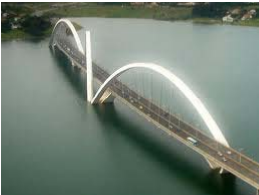
Figura 17.3 Ponte JK, Brasília.
