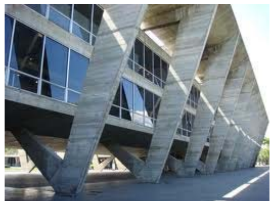
Figura 17.2 Barras de suporte de edifício.
