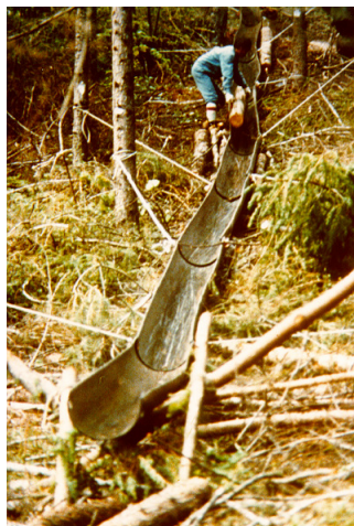
Figura 34. Transporte de toretes por calhas (Foto: FAO)
