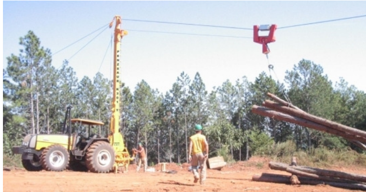
Figura 36. Sistema de cabo aéreo adaptado em trator agrícola (Foto: SAUR).
