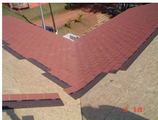
Figura 31 – Calhas executadas com telhas shingle . Fonte: TC SHINGLE, 2007.
