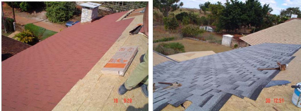
Figura 29 – Fixação das telhas shingle sobre a base de madeira. Fonte: TC SHINGLE, 2007.
