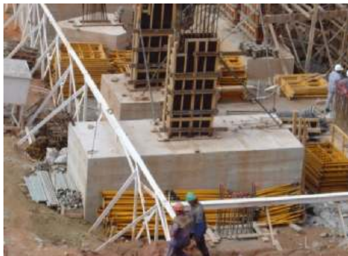
sapatas isoladas e-tower
