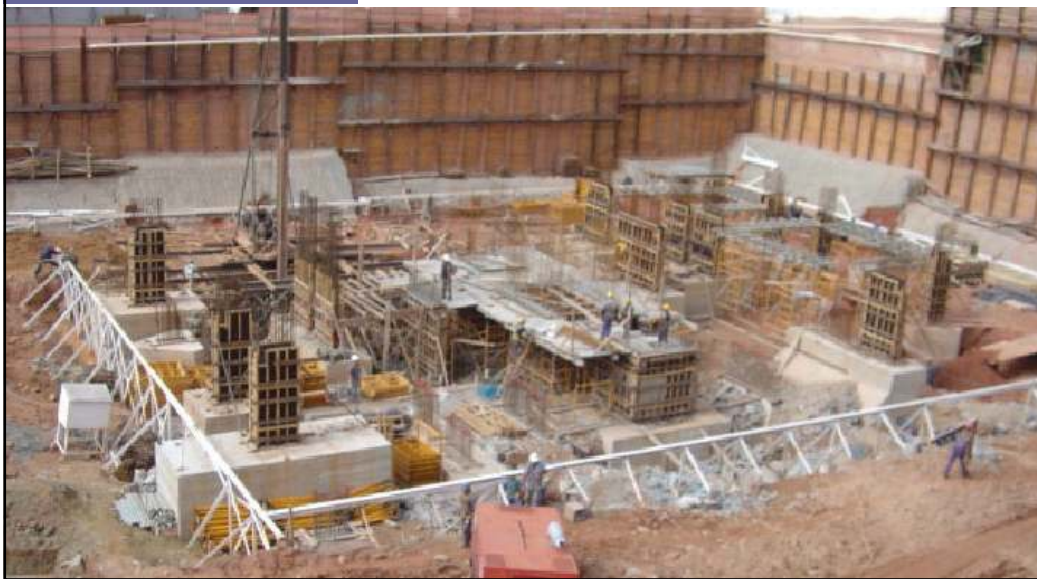
sapatas isoladas e-tower
