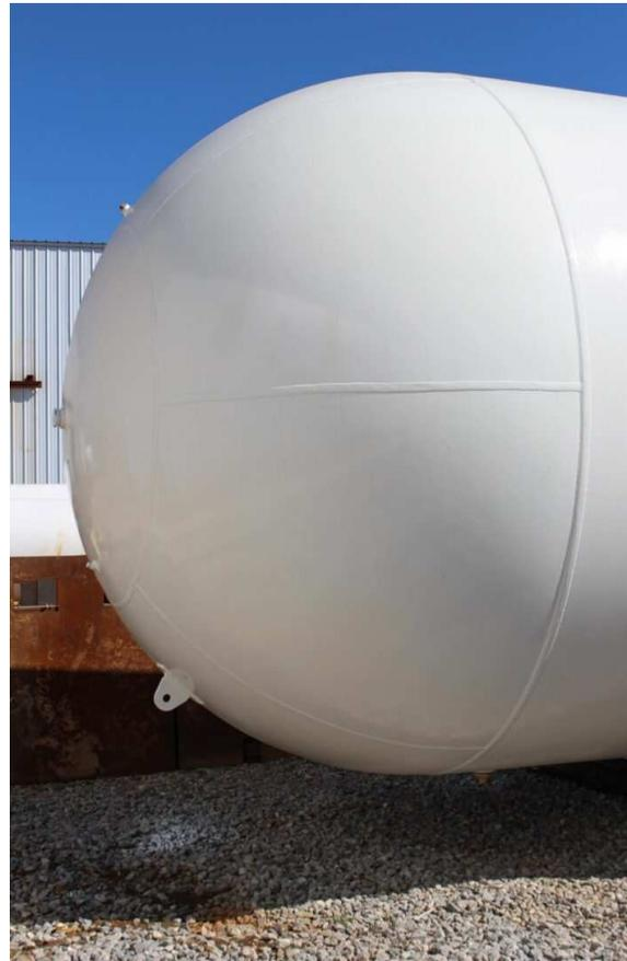
Fig.4: Junção entre tampo hemisférico e vaso cilíndrico.
