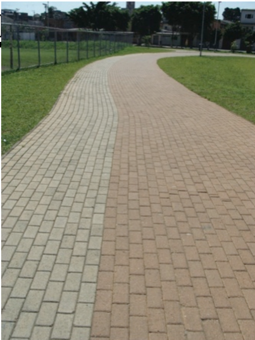
Aplicação de diferentes tipos de piso (borracha, permeável e intertravado) no Parque Linear Água Vermelha, Itaim Paulista, São Paulo.
