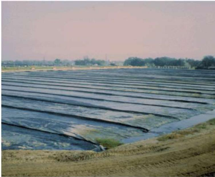
**15.4 Filtragem com algas.** Visão de um dispositivo de filtragem com algas em Falls City, Texas (EUA). Esses filtros melhoram a qualidade da água ao captar os nutrientes do efluente ou da água poluída e restaurar oxigênio. A biomassa produzida pelas algas pode ser convertida em combustível e já existem pesquisas para elaborar uma maneira custo-efetiva de fazê-lo.
