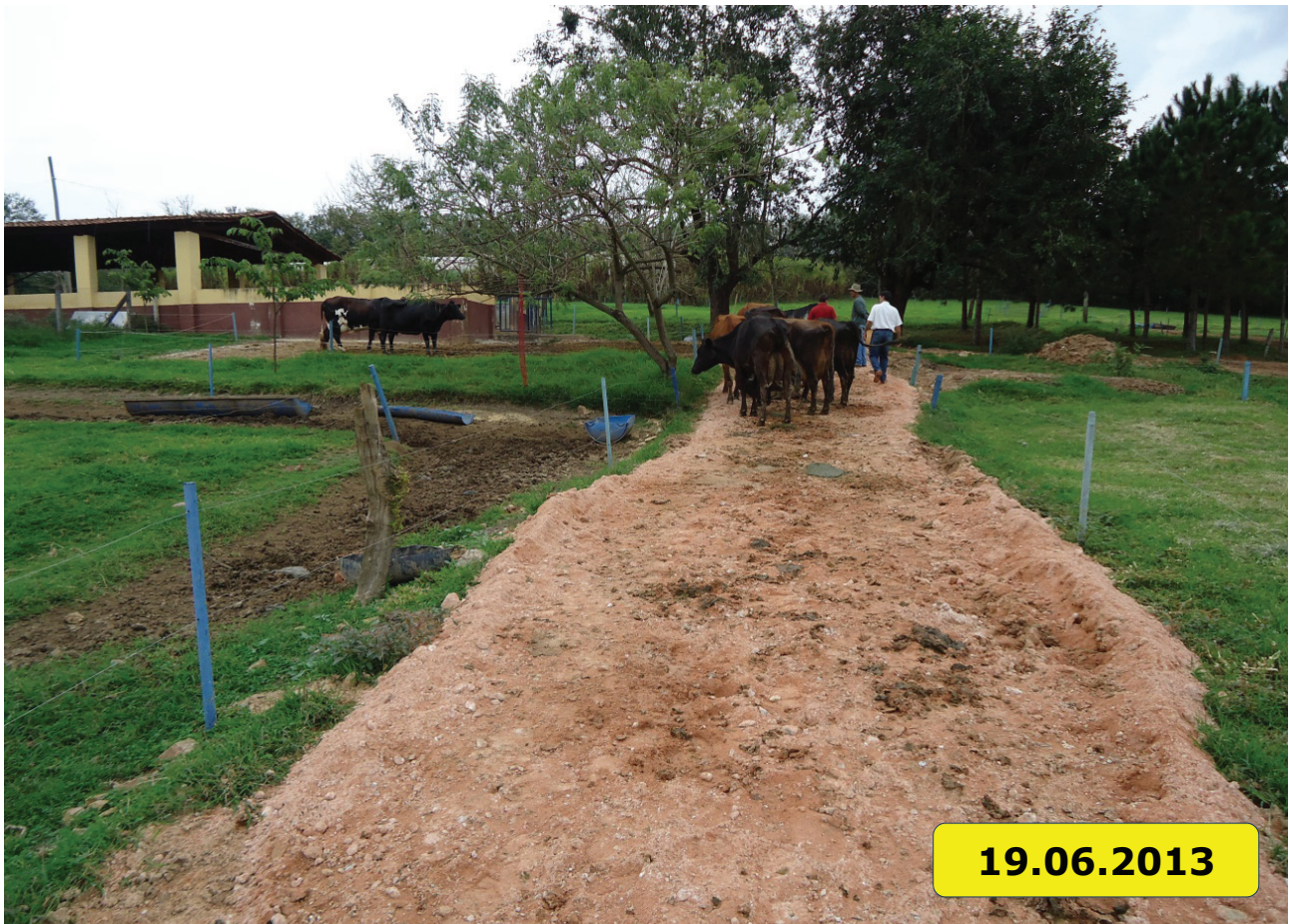
Figura 28. Cascalhamento e abaulamento dos corredores na Fazenda Nata da Serra, em Serra Negra, SP.
