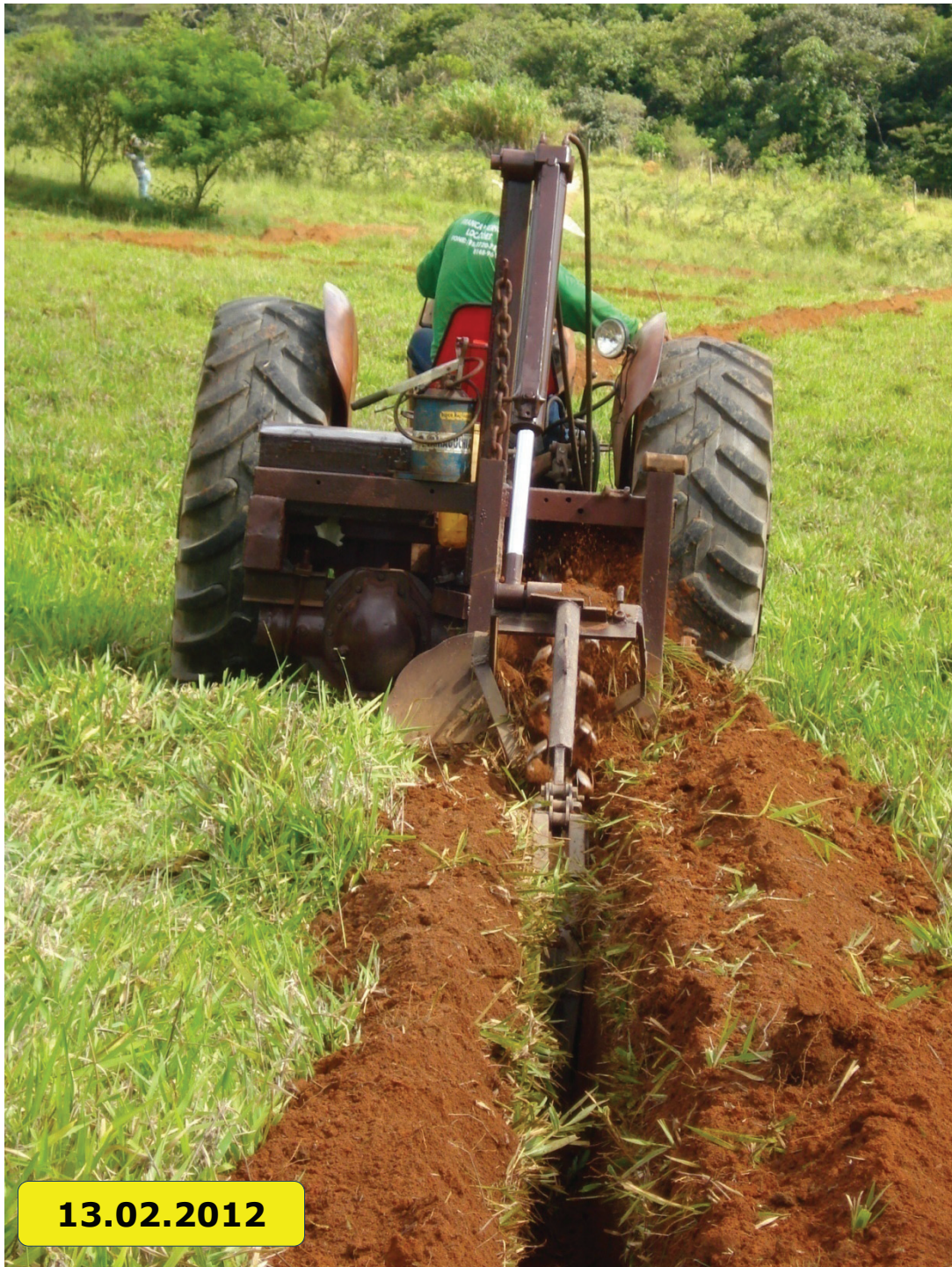
Figura 23. Valetadora abrindo os sulcos onde será implantado o sistema de irrigação no novo módulo de pastejo na Fazenda Nata da Serra, em Serra Negra, SP.
