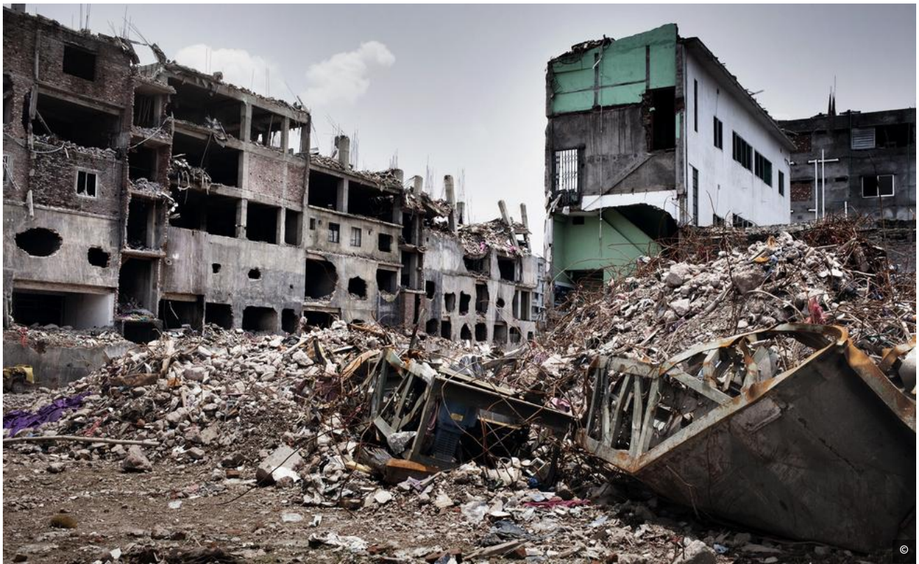
Laut des bangladeschischen Innenministers waren drei der acht Etagen illegal errichtet worden, eine neunte befand sich im Bau.
