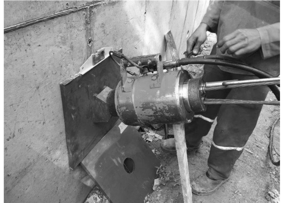
Protensão do tirante (Fonte: engestab.com.br)
