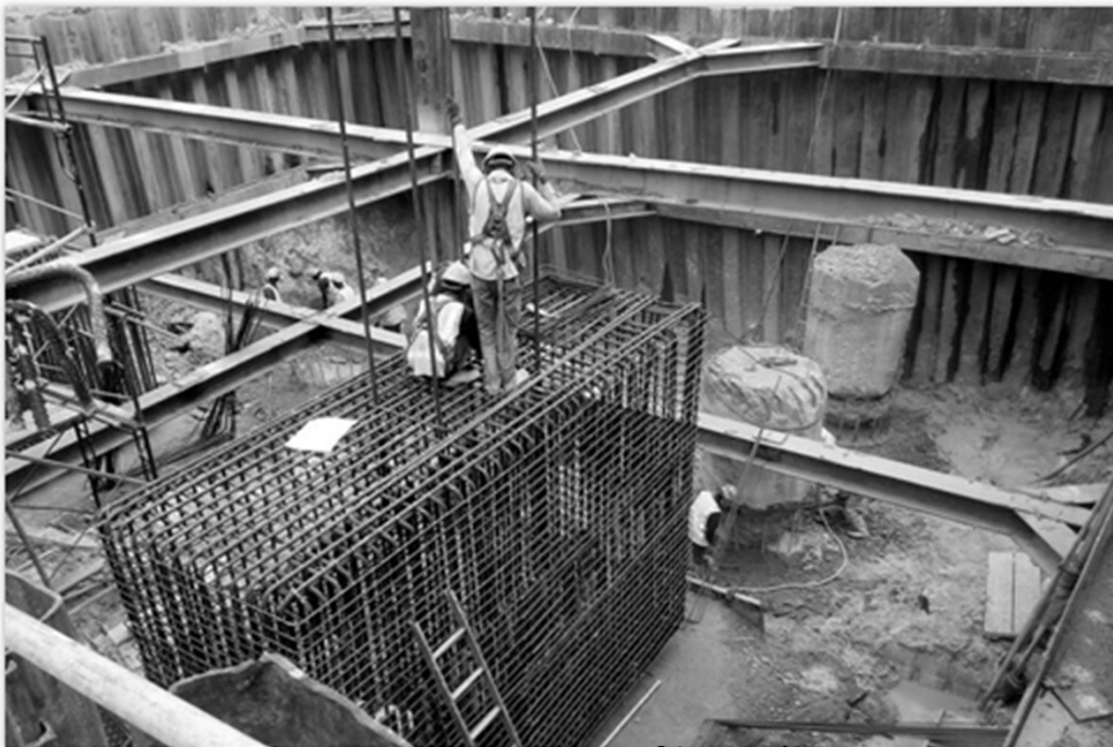
Estacas pranchas escoradas c/ perfil metálico
