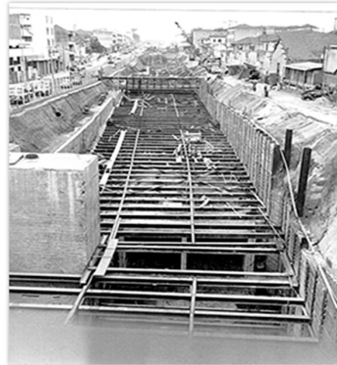
Perfil metálico + Pranchão + escoras de perfil metálico
