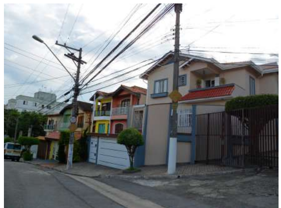
Edificações assobradadas predominam no loteamento.
