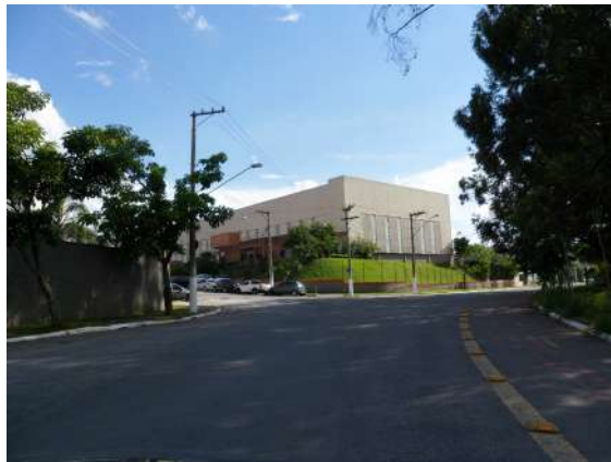
Edificações industriais na Av. Amador Aguiar.
