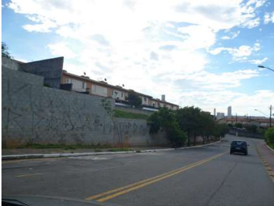
Vista dos fundos de um dos condomínios residenciais.
