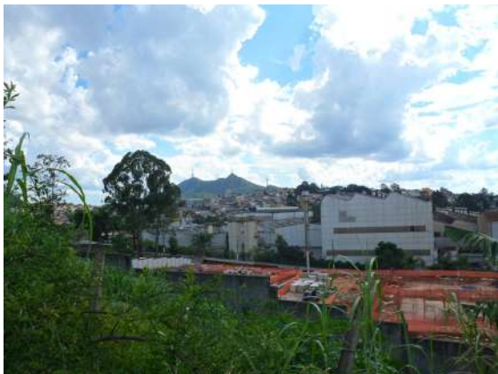
Conjunto residencial em construção. Ao fundo o Pico do Jaraguá, ponto turístico da região e de São Paulo.
