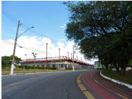
Edifício industrial na Av. Amador Aguiar.
