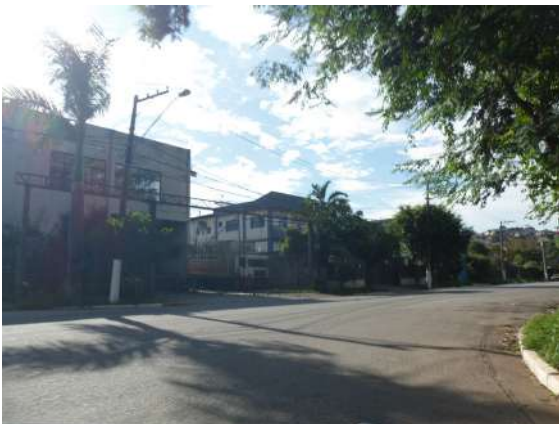
Edificações industriais na Av. Amador Aguiar.
