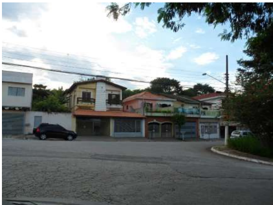
Edificações assobradadas localizadas na via de acesso ao bairro.
