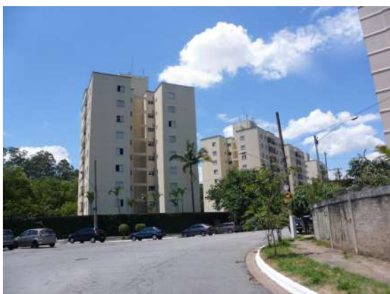
Condomínios Residenciais na Av. Cardeal Motta, com quatro torres de oito pavimentos cada.
