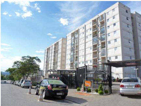
Condomínio residencial com quatro torres de dez pavimentos cada.
