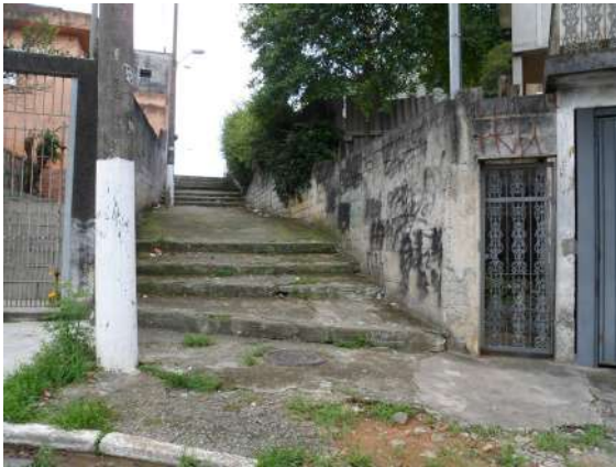
Vista da escadaria para pedestres na Rua Andresa.
