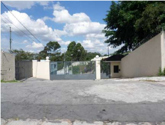
Acesso para o condomínio residencial na Av. Raimundo Pereira de Magalhães.
