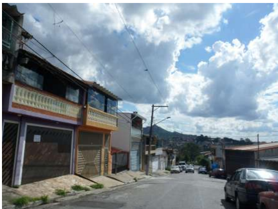
Edificações assobradadas na Rua Domênico Montella.
