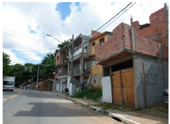
Loteamento irregular entre os edifícios habitacionais da CDHU.
