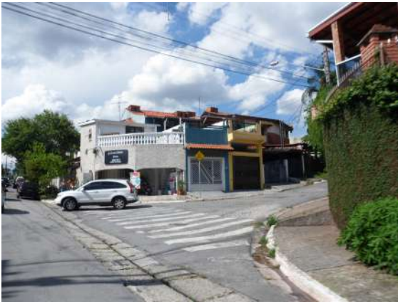
Edificação com uso comercial na esquina da Av. Agenor Couto de Magalhães.
