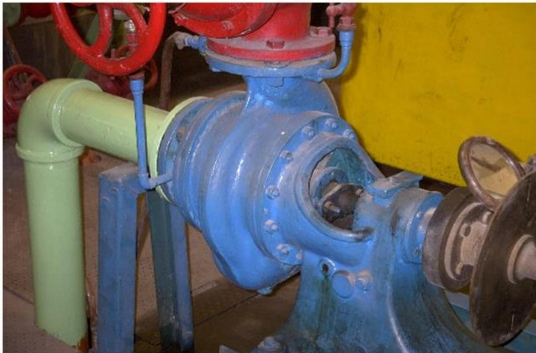
**Fig. 3.4** - Bomba "Gasmotorenfabrik Deutz", centrífuga radial.
