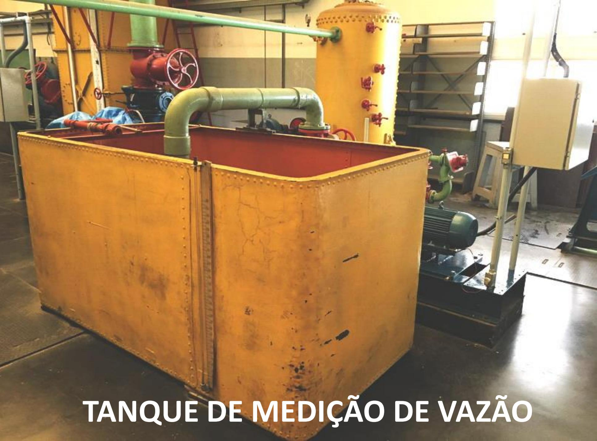
**TANQUE DE MEDIÇÃO DE VAZÃO**
