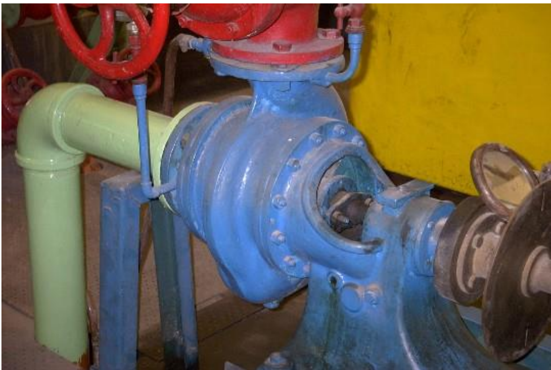
Fig. 3.4 - Bomba "Gasmotorenfabrik Deutz", centrífuga radial.
