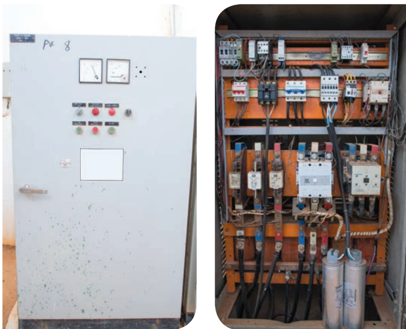
Quadro de comando ou chave de partida estrela-triângulo
