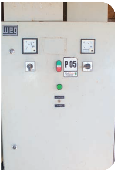
Quadro de comando ou chave de partida série-paralelo
