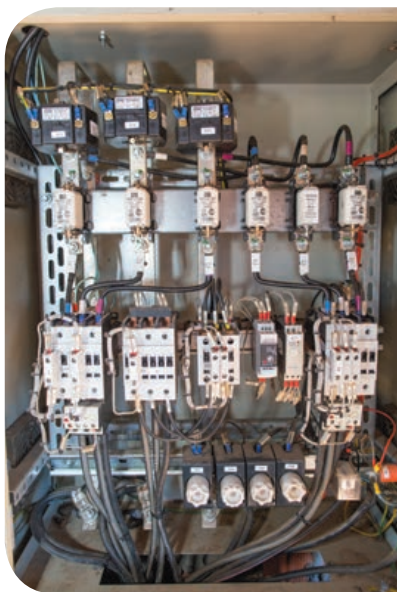
Quadro de comando ou chave de partida série-paralelo
