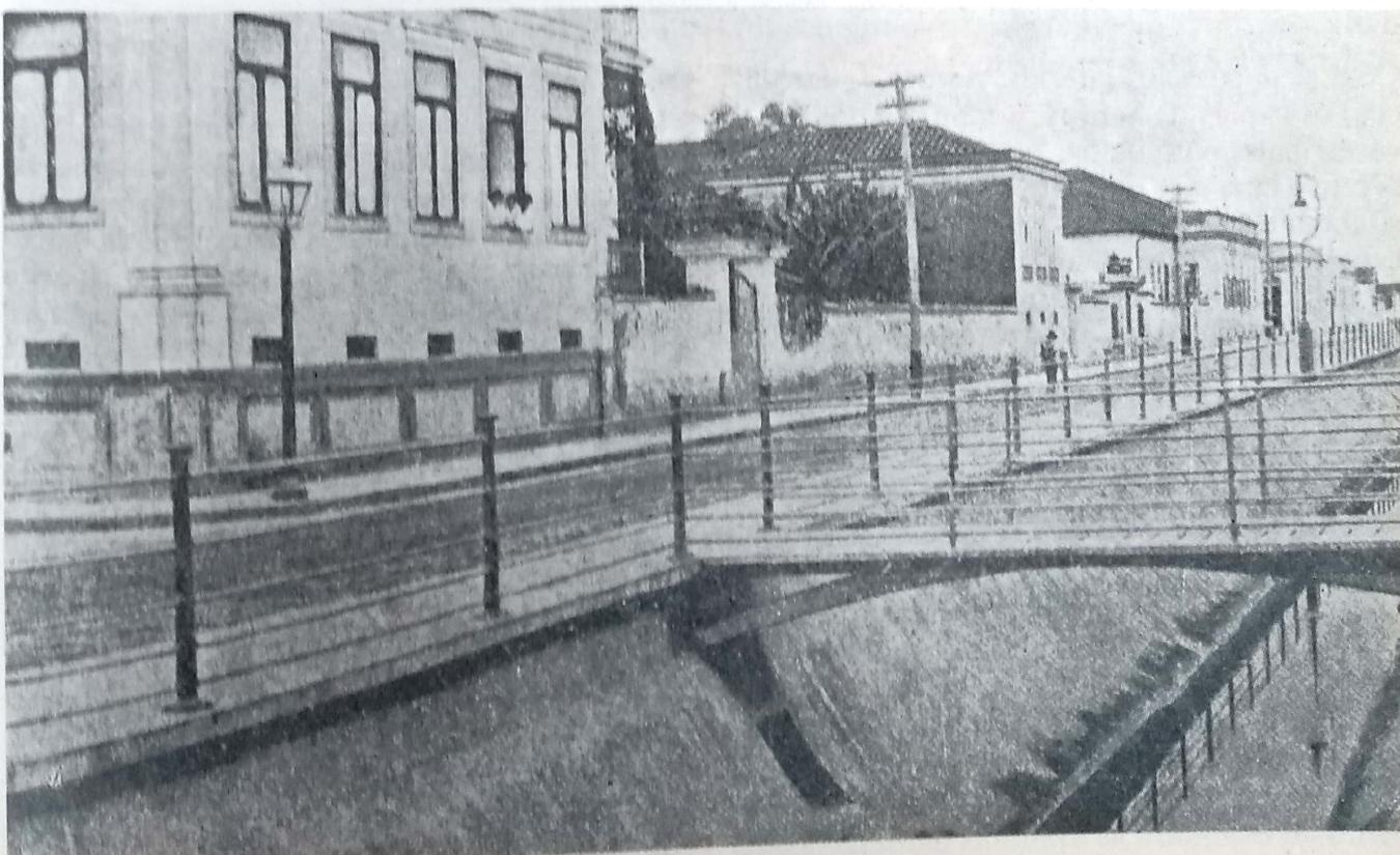
*Saneamento de Santos - canal de drenagem superficial (concreto armado)*
