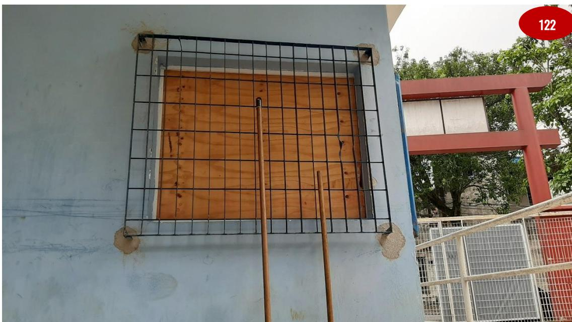
Parque Takebe – Madeira instalada para substituição do vidro danificado na sala da Guarda Municipal. Instalada de maneira provisória, a madeira se mantém no local desde outubro de 2020.
