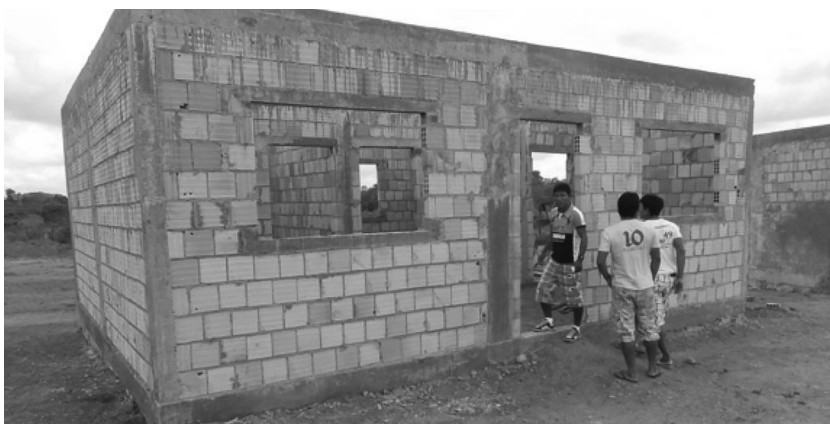
Figura 5. Construção das casas de alvenaria na aldeia Rap Kô.
