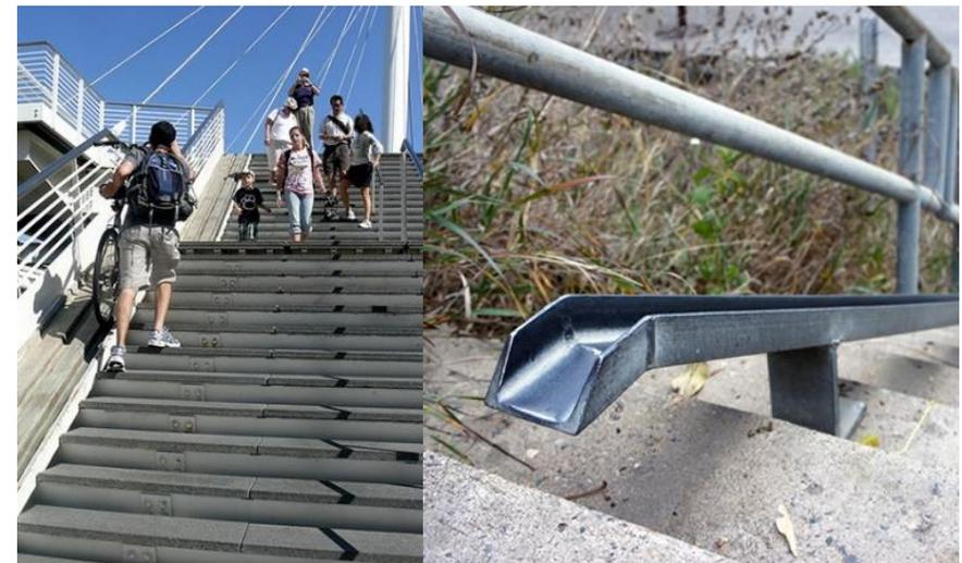
Figura 119: Canaleta inclinada para transporte de bicicletas em escadas
