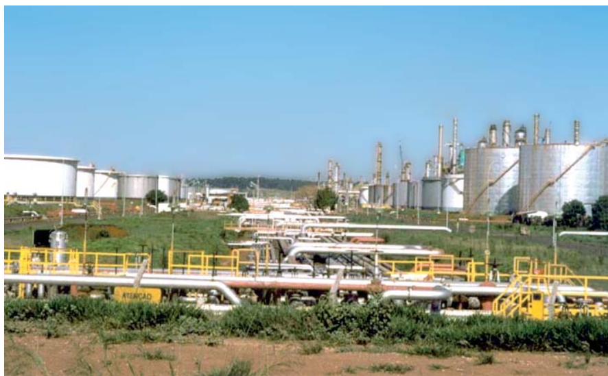
Figura 3.1.3 Refinaria de Paulínia
