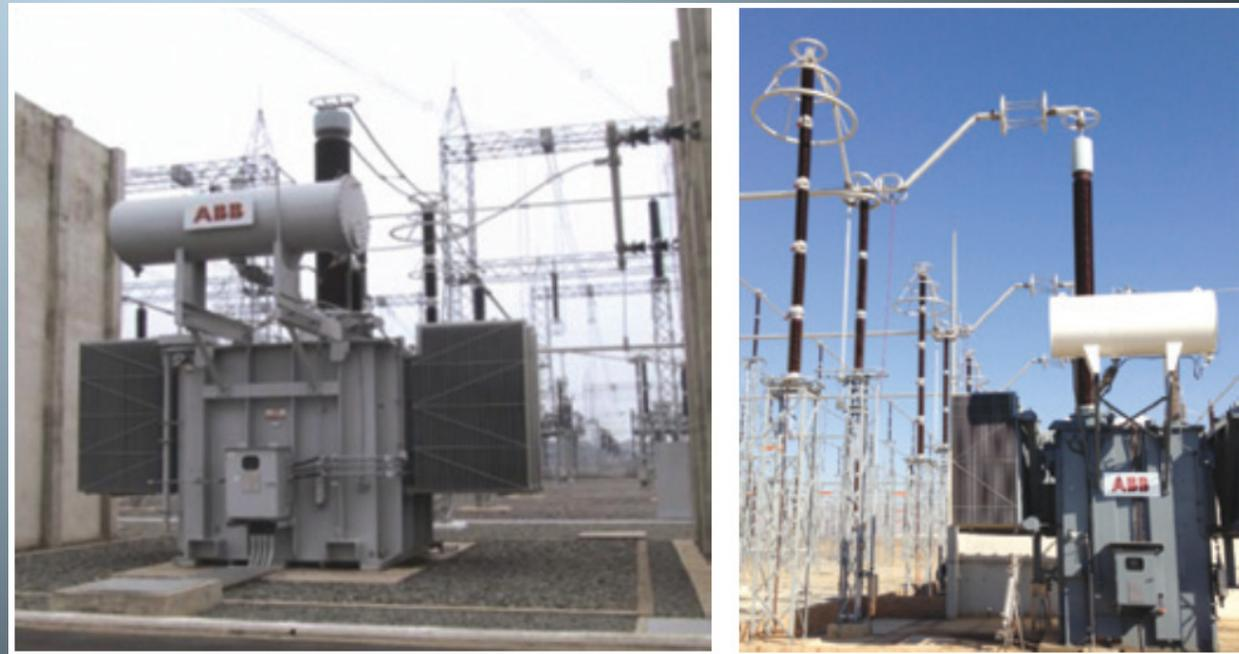
Reatores em derivação: 40 Mvar-525/ $\sqrt{3}$  kV e 133 Mvar-765/ $\sqrt{3}$  kV
