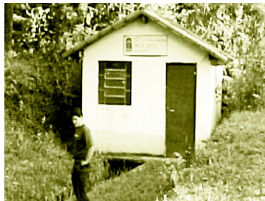
Figura 4.9 - Casa de máquinas e canal de fuga de uma microcentral hidrelétrica
