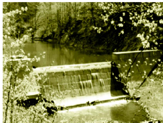
Figura 4.2 – Barragem de concreto com vertedouro incorporado
