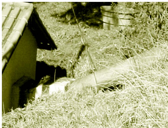
Figura 4.8 - Conduto forçado e bloco de ancoragem da casa de máquinas
