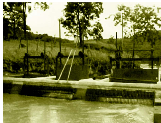
Figura 4.3 – Tomada d'água vista do lado de montante
